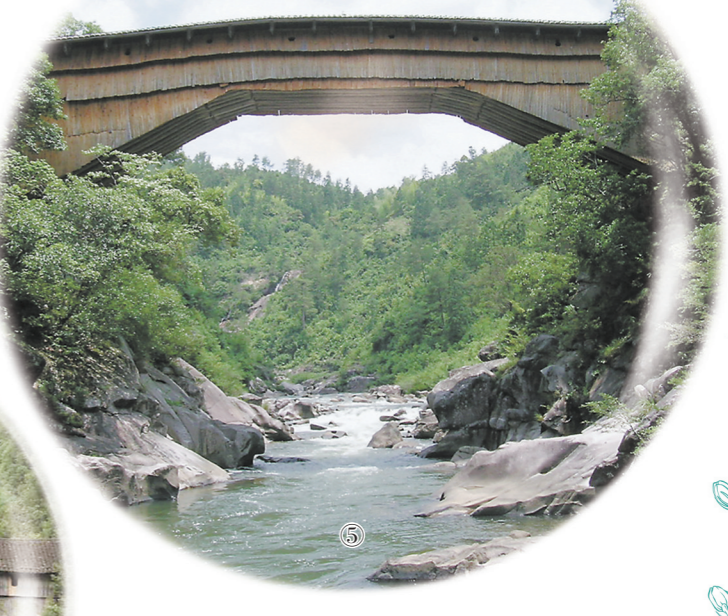
①屏南千乘桥 本报记者 王毅 摄 ②寿宁杨梅州桥 ③寿宁飞云桥 ④屏南万安桥 本报记者 王毅 摄 ⑤屏南百祥桥 ⑥寿宁鹳峰桥 ⑦政和龙潭桥
