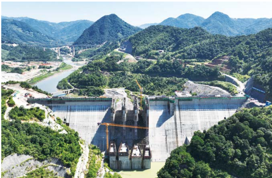
2022年7月22日,霍口水库大坝封顶
